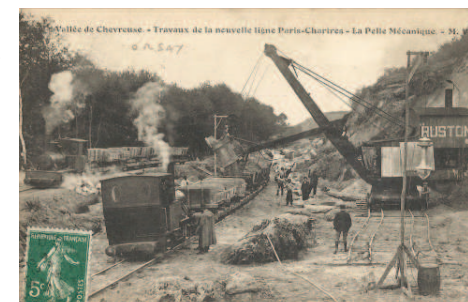
Construction de la ligne à l'aide d'une pelle mécanique
