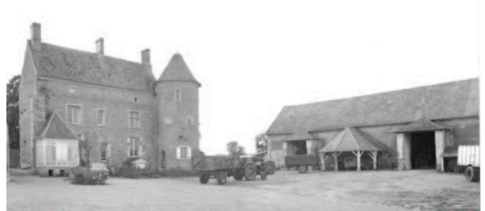
Le manoir des Carneaux et la grange à porches et aire de battage couverte en 1973, avant rénovation (Cl. Inv. Corbierre).
