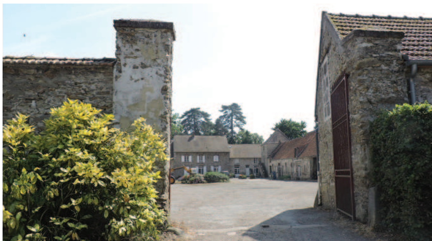
Entrée principale Nord, avec le logis en fond de cour et la citerne au centre. A droite le pavillon avec l'escalier extérieur, l'écurie et le passage vers le jardin
