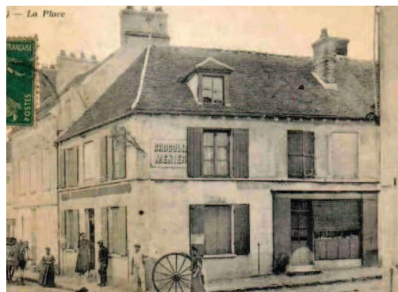
Ancienne lucarne à croupe devenue lucarne à pignon au XXe siècle
